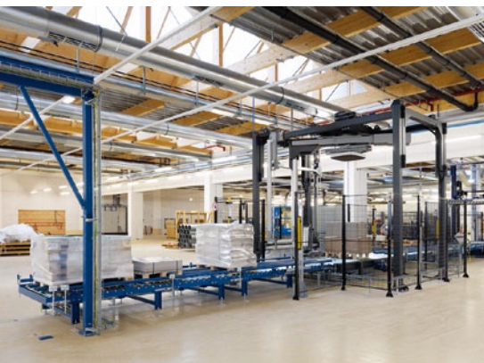
Die Förderstrecke mit automatischer Konturenkontrolle, Umreifung, Wicklung und Etikettierung bewältigt Paletten mit großen Maßunterschieden.
