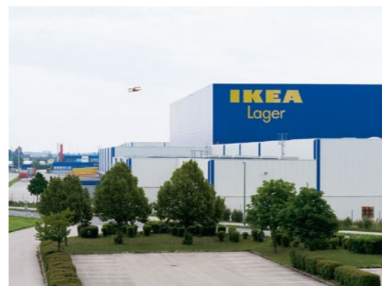
Das Hochregallager liegt in der Einflugschneise des Welsener Flughafens. Das Szenario einer Aufstockung der Halle scheidet nach längeren Verhandlungen aus.
