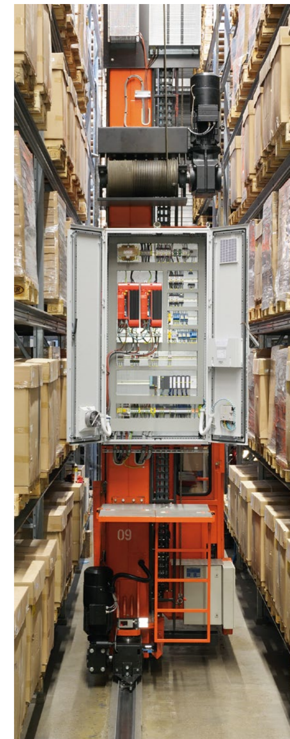
Nach drei Tagen Umbauzeit und Testlauf sofort wieder einsatzbereit: Regalbediengerät mit aktuellem S7-Schaltschrank und neuen Fahr- und Hubantrieben.
