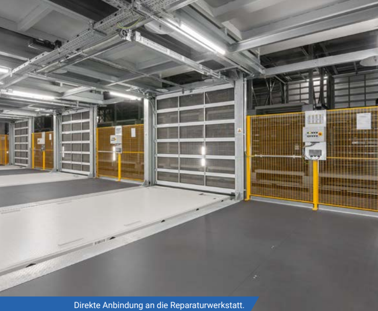
Direkte Anbindung an die Reparaturwerkstatt.
